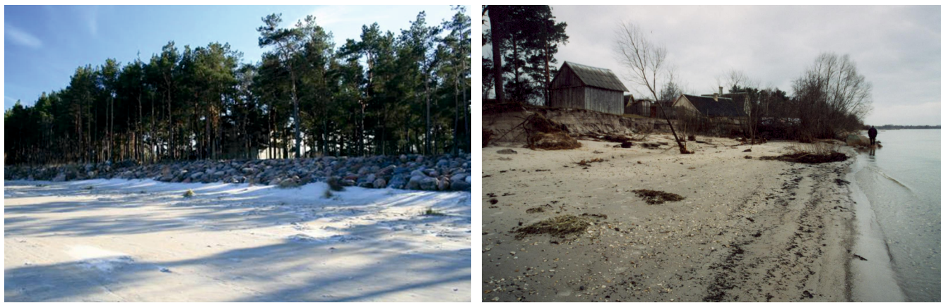
7. att. Kreisajā pusē krasta preterozijas būve (laukakmeņu rip-rap) Lapmežciemā pie Starpiņu mājām (2010. gads). Labajā pusē pie „veco” krasta nostiprinājumu gala notikusi krasta erozijas pastiprināšanās Bigauņciemā 2001. gada novembra vētrās.
