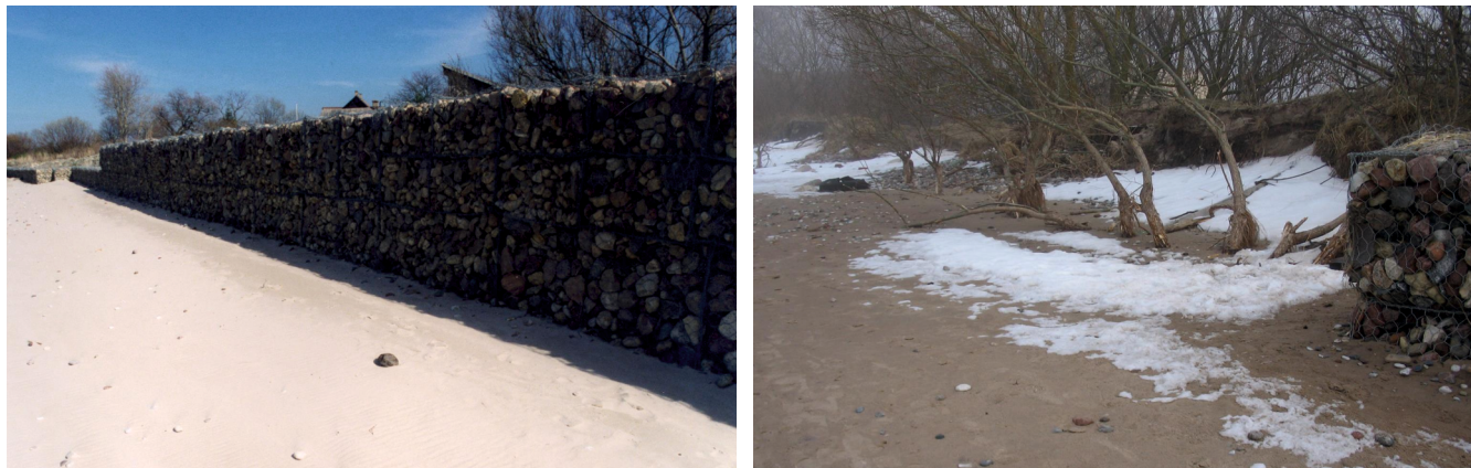
6. att. Kreisajā pusē Gabionu otrās kārtas centrālā daļa pēc to ierīkošanas 2003. gada pavasarī. Labajā pusē krasta erozijas pastiprināšanās vētras laikā virs fona līmeņa pie nostiprinājumu ZA gala. (2005.03.)
