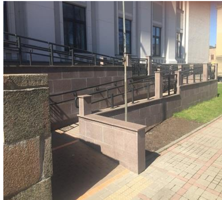
Pēc uzbrauktuves izbūves
