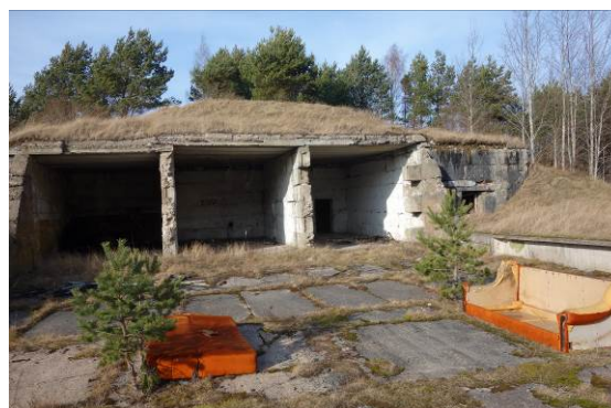
1.1.16. attēls. Krasta aizsardzības baterija Lūžņā
