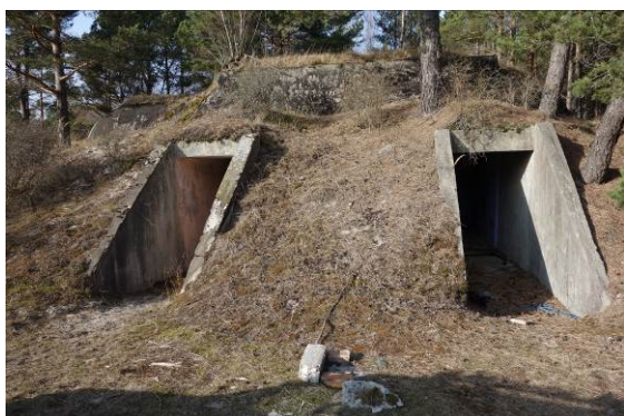
1.1.15. attēls. Krasta aizsardzības baterija Lūžņā
